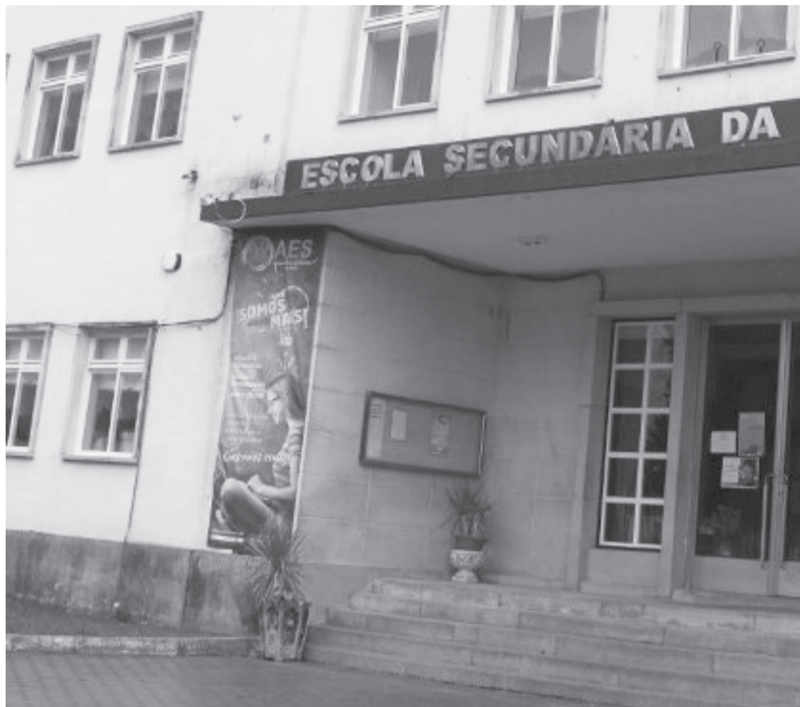
Pormenor do edifício principal da Escola Secundária já desativado para as obras de requalificação.
